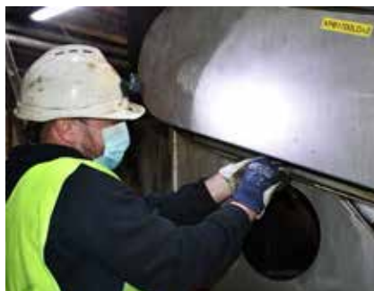
Voor sommige installaties kan Renewi de preventieve onderhoudsbeurten op jaarbasis vastleggen. Deze zijn zo op maandbasis 97 à 98% van de tijd operationeel. (Foto VC)
