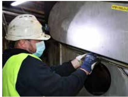
Pour certaines installations, Renewi peut établir les intervalles de maintenance préventive annuellement. Sur une base mensuelle, Renewi parvient à les maintenir opérationnelles 97 à 98% du temps. (Photo VC)
