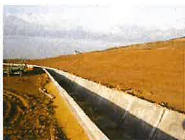
Fossé de collature
