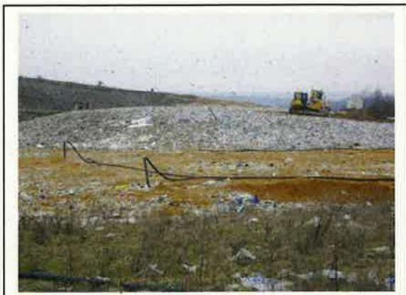
La première phase des travaux de réhabilitation du secteur 1 a débuté par le raclage des couches supérieures jusqu'à la couche d'argile déjà en place. Cette dernière a été complétée en 2008 par une couche d'argile complémentaire de 60 cm ainsi que par une couche de reprofilage. Le réseau de collecte du biogaz a également été adapté à la nouvelle configuration des lieux.
