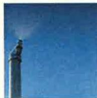
Un système de pulvérisation autour du site permettrait si besoin de combattre les odeurs des déchets déversés, en dispersant des produits neutralisant. Ce système s'enclenchait automatiquement en fonction de la vitesse et de la direction des vents. Ce système n'est actuellement plus en service.
