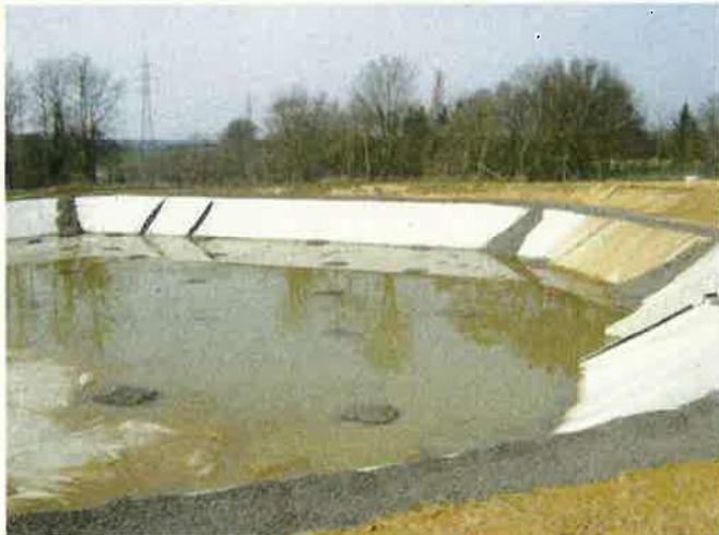
Un bassin d'orage temporaire permettant d'absorber rapidement un volume d'eau important, a dès lors été créé en 2008. Celui-ci n'étant plus nécessaire, il a été recouvert en 2020. Le bassin d'orage définitif est, quant à lui, pleinement opérationnel depuis mi-2010.
