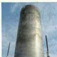
En cas de surplus de biogaz ou de problème technique pour l'alimentation des moteurs, le biogaz est envoyé vers les torchères\* et détruit à 1200°C. L'ensemble de nos torchères permettent d'assurer la destruction de l'intégralité du biogaz en continu si nécessaire.
