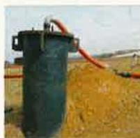
Les puits de dégazage sont constitués d'un drain vertical qui traverse tout le massif des déchets. Chaque puits fait l'objet de contrôles réguliers afin de mesurer, entre autres, la dépression appliquée et la teneur en méthane du biogaz collecté.
