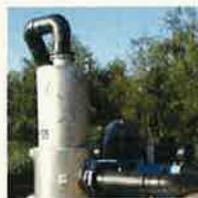
Grâce à ces extracteurs, une dépression adéquate est maintenue au niveau du massif des déchets de manière à éviter les émissions passives de gaz dans l'atmosphère.
