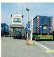
Les ponts-basculés, régulièrement étalonnés, sont équipés d'un portique de détection des matières radioactives et d'un système de contrôle par caméras.
